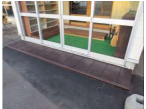
第2庫裏玄関 段差をつけ水溜りを解消
