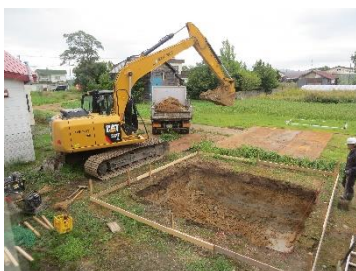
9月16日 掘削工事
