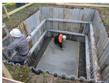
基礎ベースコンクリート(捨てコン)打設
