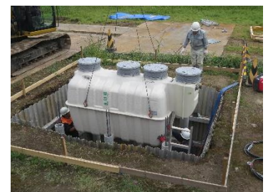
浄化槽(10人槽)設置
